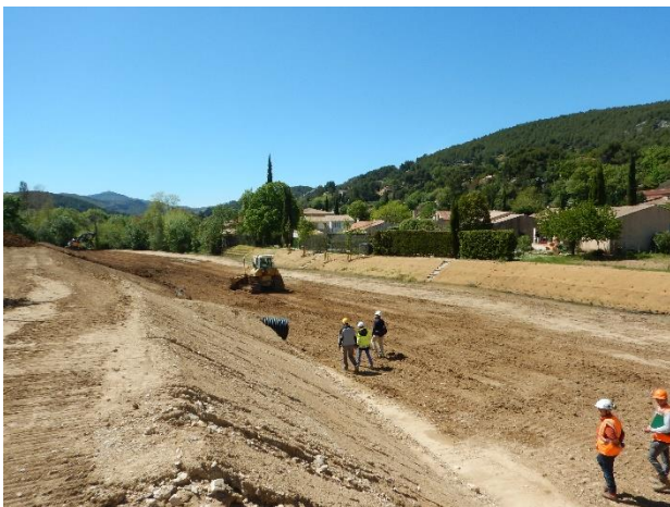
Chantier 2019 SMBVH de création du parc de la Confluence à Auriol
