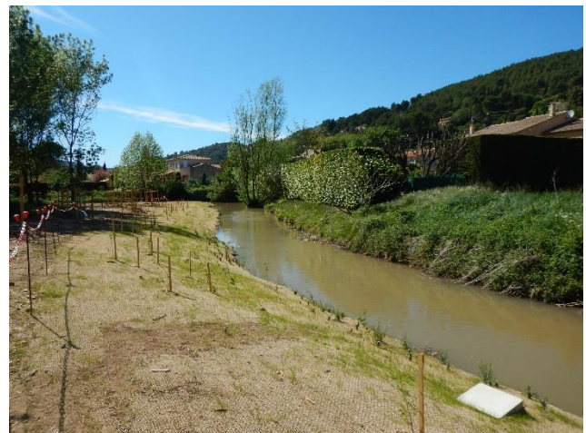
Chantier 2019 SMBVH du Parc de la confluence à Auriol
