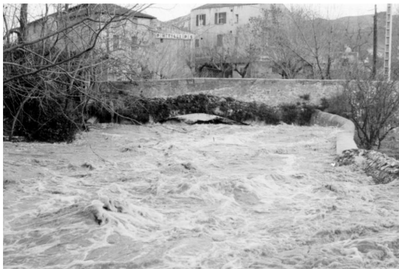
Le vieux pont Romain de st Marcel lors de la crue de 1978 Source : Jean Luc Fontaine – http://les-cahiers-du-sud.eklablog.com/
