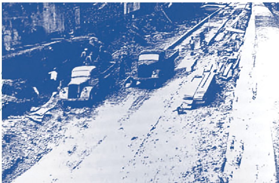
CURAGE ET CUVELAGE DE L'HUYEAUNE
